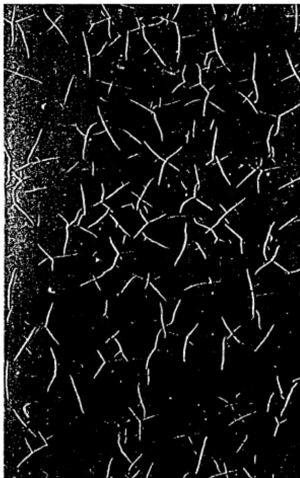
Рисунок 5 — Образование трещин лакокрасочного покрытия в виде «птичьих следов»
